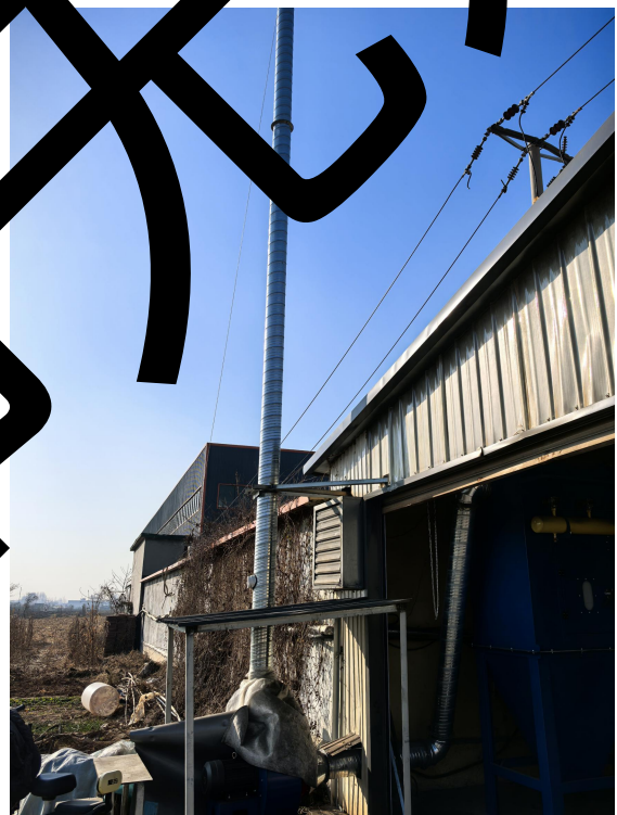
磨边废气：布袋除尘器、15米排气筒 DA001
