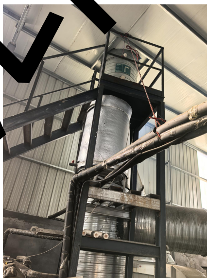
调漆、喷漆废气，烘干废气，烘干过程天然气燃烧废气：过滤棉+两级活性炭吸附装置、15 米排气筒 DA001
